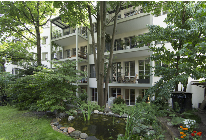
Gartenansicht mit neuen Balkontürmen
