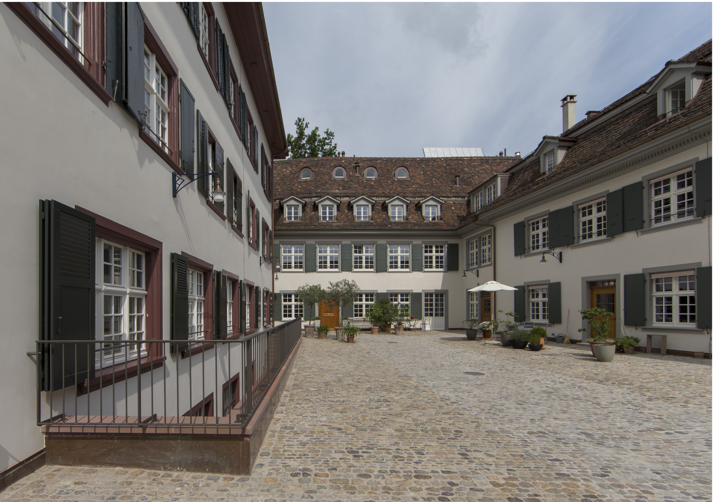
Innenhof mit behindertengerechter Pflasterung
