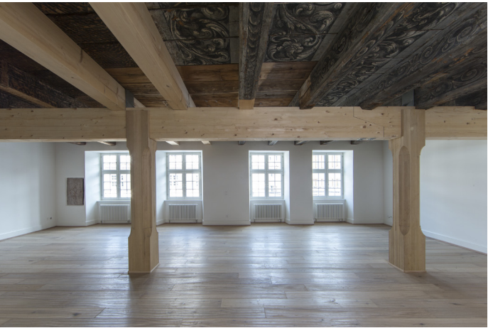
Deckenmalerei mit Grisailleranken
