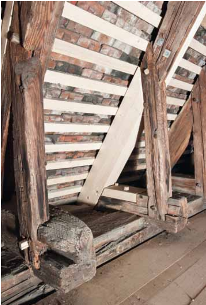
Dachfuss: Schwellen mit aufgekämmten Stummelbalken
