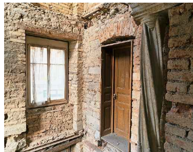
Die Schaufassade des «Bären» von innen gesehen: Diese einzigartige Hotelfront gegen die Parkstrasse liess der Zürcher Architekt Kaspar Otto Wolff 1881 einfach ein paar Meter vor die alte Fassade bauen.
