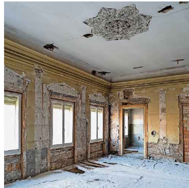
Der prächtige Ochsenaal diente als Festsaal, bevor er in den 1920er-Jahren in Hotelzimmer unterteilt wurde. Der Saal ist nach knapp hundert Jahren erstmals wieder sichtbar.
