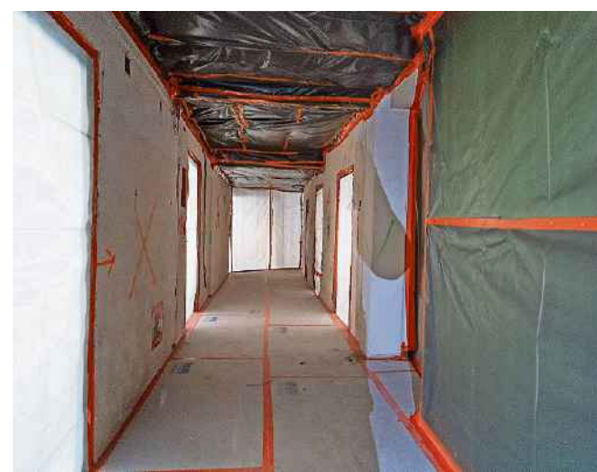
Fast futuristisch muten die langen Hotelflure jetzt an: Sie sind dicht mit Plastikfolien eingepackt. Spezialisten befreien Wände und Böden von Schadstoffen aus früheren An- und Umbauten.
