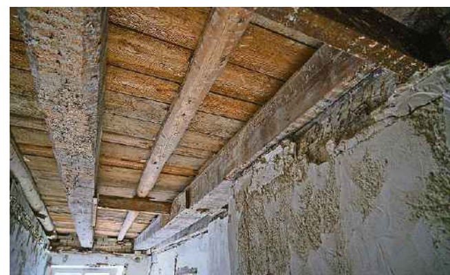
Auch wenn es bröckelt und blättert: Die Bausubstanz ist gut. Der Tannenholzbalken rechts im Bild ist 24 Meter lang – und wird auch nach dem Umbau wieder eine tragende Funktion haben.
